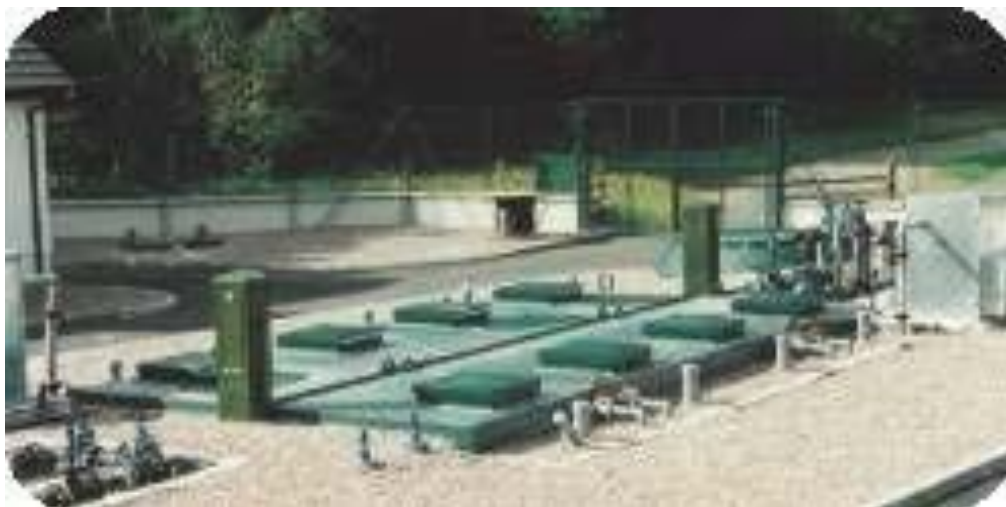
Figura 7 Gradsko postrojenje za preradu za 1500 osoba. Dve linije SAF procesa (2 x 4 kade u seriji) ( www.copa.co.uk )
