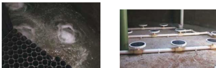
Figura 6.- Levo: Sklop BIO-BLOK medija za punjenje, gde se primećuje gruba aeracija mehurića. Desno: sklop difuzora.
