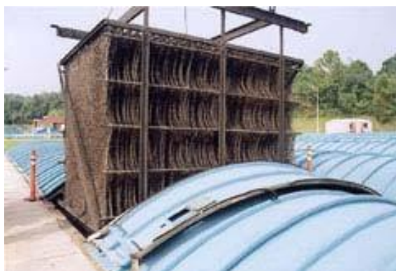
Figura 3.- "Ogrlica" pričvršćena konopcem. Čista (levo); kolonizovana biofilmom (desno)
